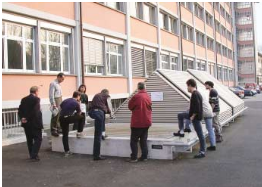
Besichtigung der Holzheizungsanlage von Bellinzona. Sie wärmt seit zwei Jahren verschiedene Gebäude und Schulen im Quartier Torretta.
